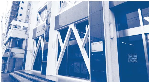
○耐震補修工事の実施(城東営業部) 自然災害(地震)で建物が倒壊するのを防ぐための工事を実施しました。
