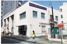
2 八幡支店 市川市八幡2-4-5 047(334)2511
